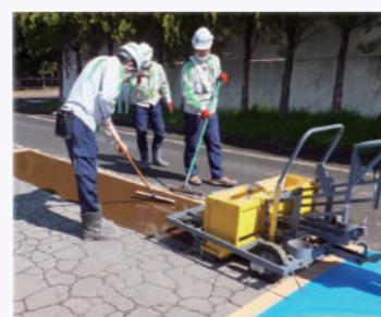
予防保全のための常温表面処理工法
