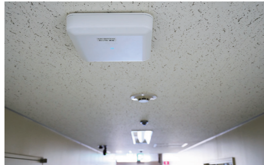
スイッチのほかに無線アクセスポイントも新しい機器に置き換えた
