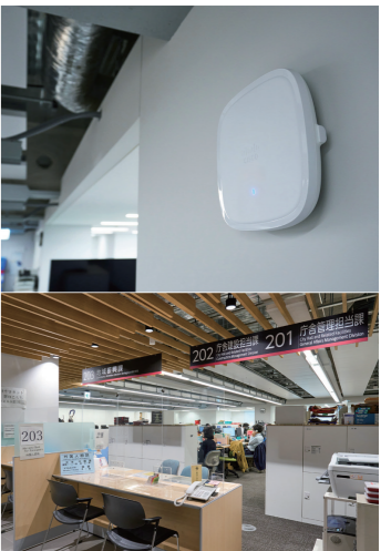
新庁舎に設置された無線LANルーター(上)。西棟2階には地域振興や街づくりの部署が入居(下)
