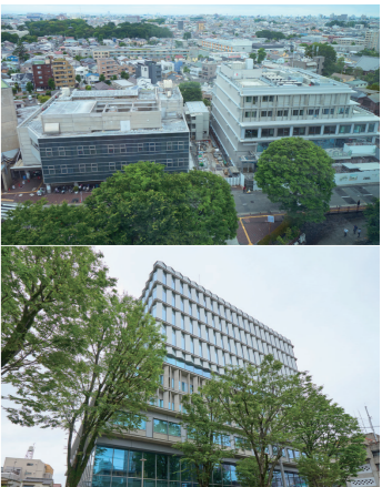
2024年春に新庁舎第1期棟の西棟(上右)と東棟(下)が完成。第三庁舎(上左)は2期工事予定
