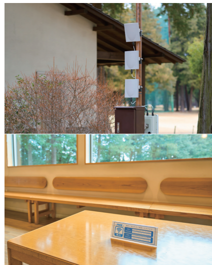
売場に設置したPicoCELAの子機。パネルが1cmずれてもWi-Fi電波が届かないため、設置は繊細な作業
