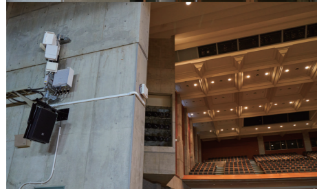
イニシアティブ交流スペース向け(上)には実績のあるミリ波アンテナを設置。講堂大ホール(下)にはSub6とミリ波アンテナを設置。
