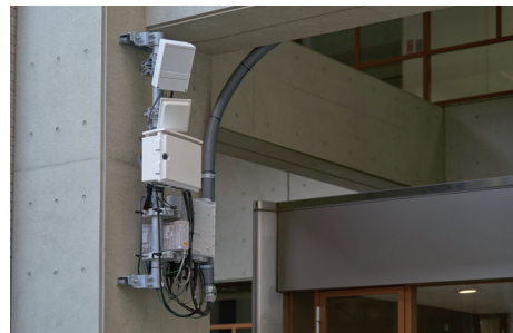
ローカル5G用アンテナ。屋外はおもにSub6(上)を設置し、運動場(下)を含め、キャンパス内の広範囲を効率的にカバー。
